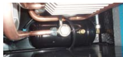
Deposito de control de presión SIL 5,5 a SIL 10. Tank pressure control for SIL 5,5 to SIL 10.
